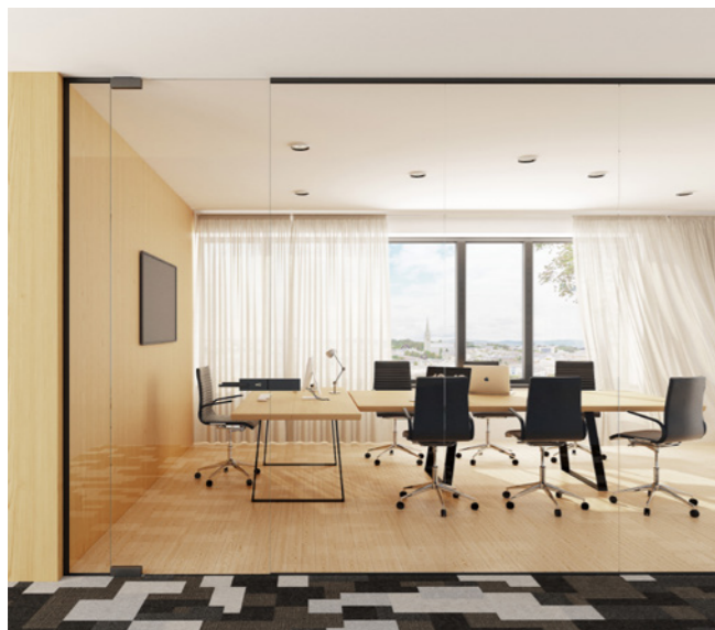
Jednokridlové sklenené dvere s PT pántami na celú výšku
